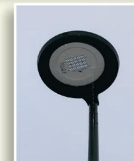
Remplacement des six luminaires vétustes par des luminaires LED. →
